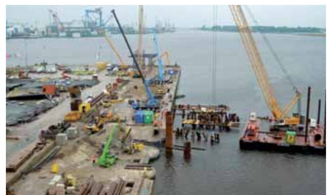
Liegeplatz 54 in der Bauphase
