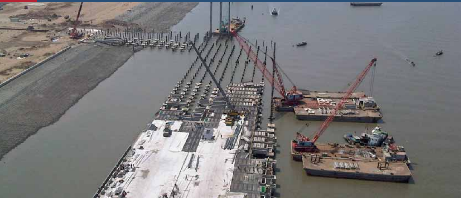
Bauphase Containerterminal Cai Mep in Südvietsnam
