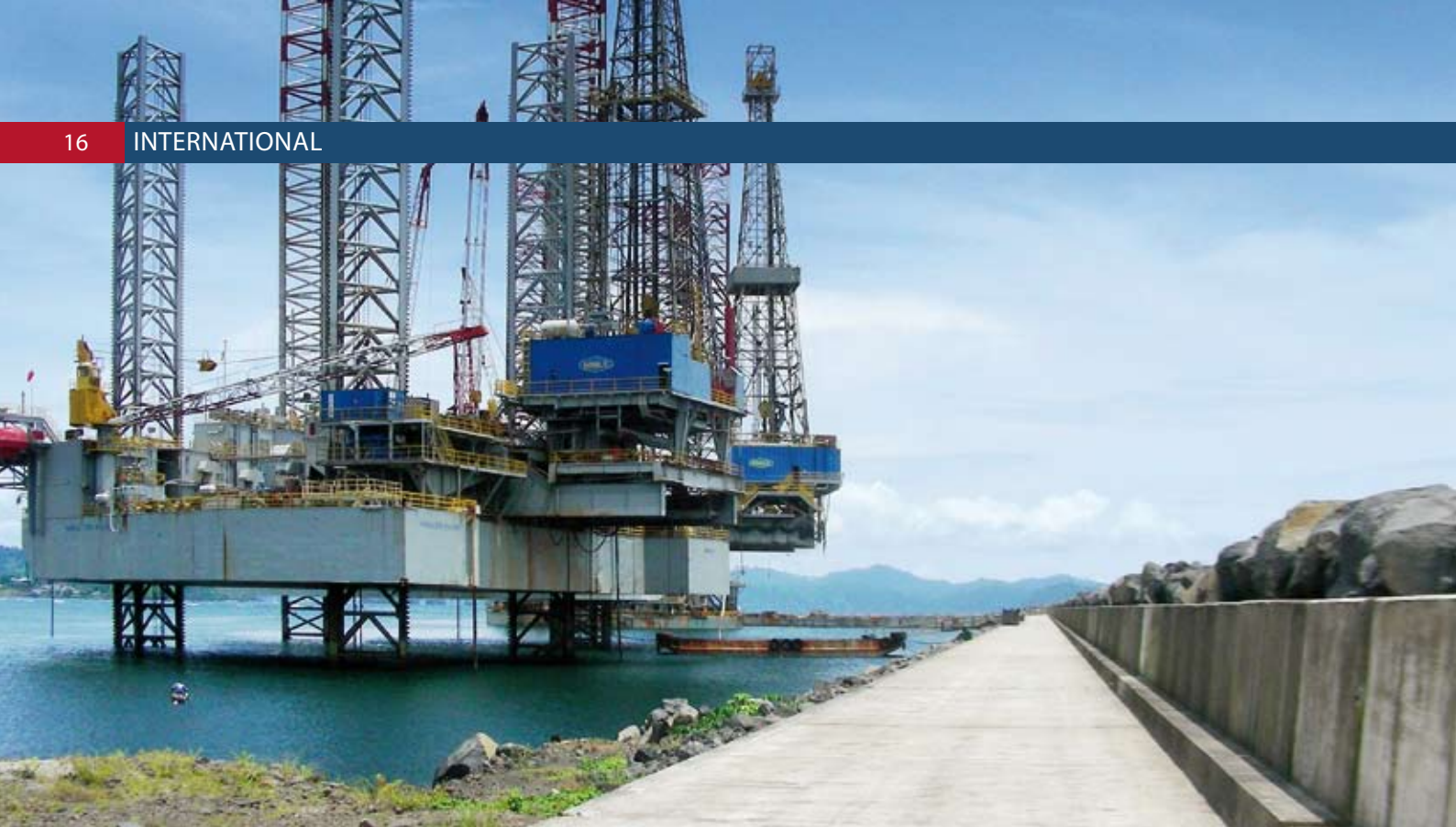
Explorationsplattform der Nobel Corporation im sicheren Hafenbecken entlang des Wellenbrechers.
