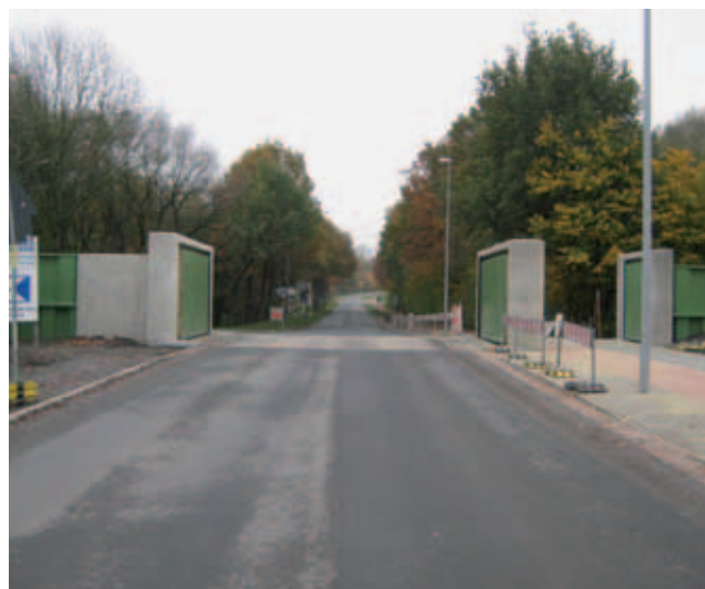
Bild 7a, 7b: Deichschart an der B74 – Neubau des Betonbauwerks und Erhöhung der Gradiente der B74 um 1,05 m
