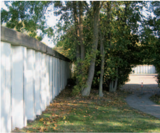
Bild 5a, 5b: Hochwasserschutzwand aus Stahlspundbohlen vor und nach Erhöhung
