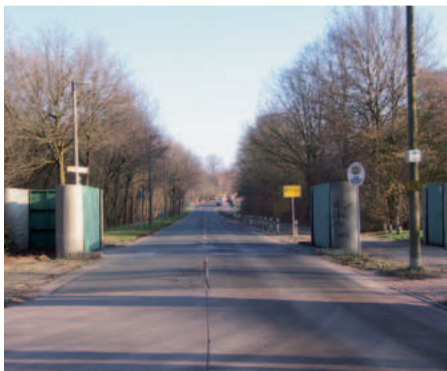
Bild 7a, 7b: Deichschart an der B74 – Neubau des Betonbauwerks und Erhöhung der Gradiente der B74 um 1,05 m
