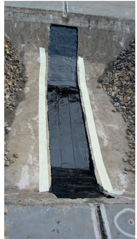
Abb. 3: Raumfuge – Asphaltübergang im Bereich des Troges
