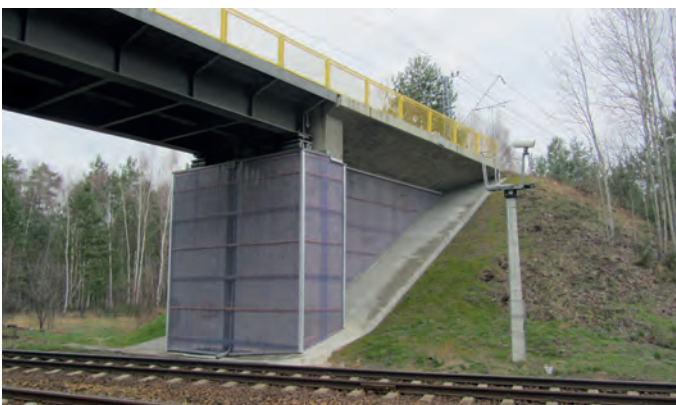
Abb. 6: Widerlager mit Böschungspflaster und Spritzwasserschutz
