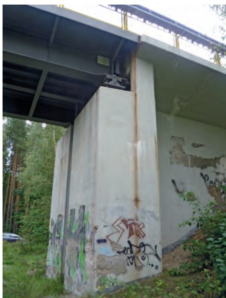
Abb. 1: Ansicht des westlichen Widerlagers vor der Instandsetzung
