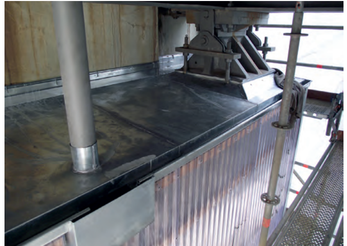
Abb. 5: Verblechung der Auflagerbank
