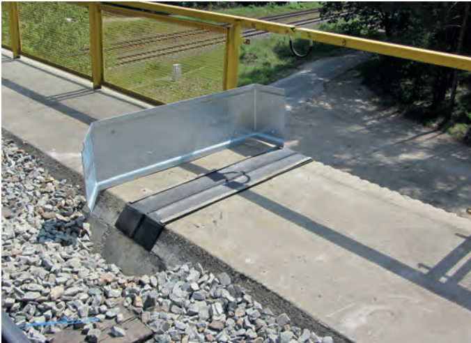
Abb. 4: Raumfuge – Klemmfugenband und Abdeckblech im Gehweg-Bereich
