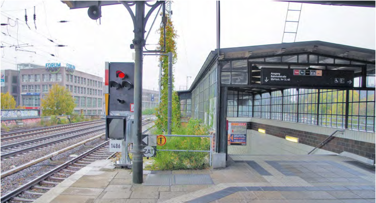
Bestehender Treppenzugang S-Bahnsteig
