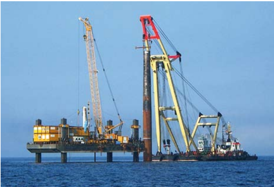
Abb. 9/10: Fertigung Monopile onshore / Rammung Monopile
