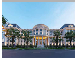
Oberster Volksgerichtshof Vietnam, Hanoi – Neubau auf einer Fläche von 6.417 m²
