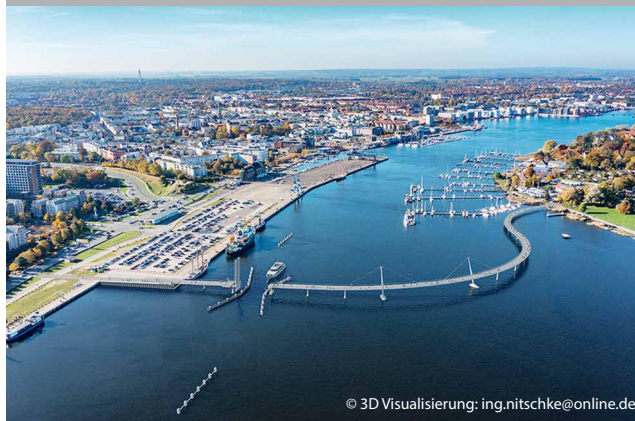
Warnowbrücke, Rostock – Rad- und Fußverkehrsbrücke
